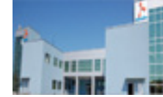
Abhazya AquafonGsm Tesisleri Kompleksi
